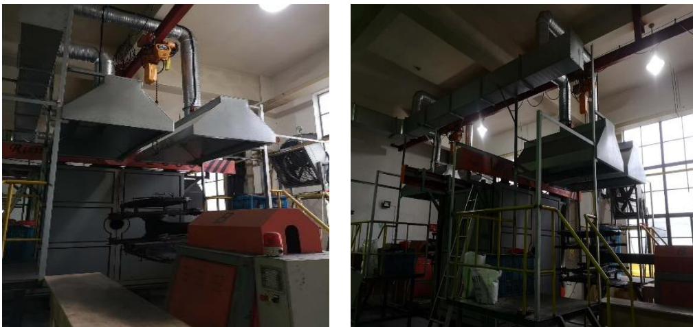
图 7-10 一号板滚塑吸风罩及管道
